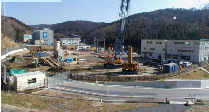
主立坑掘削状況
